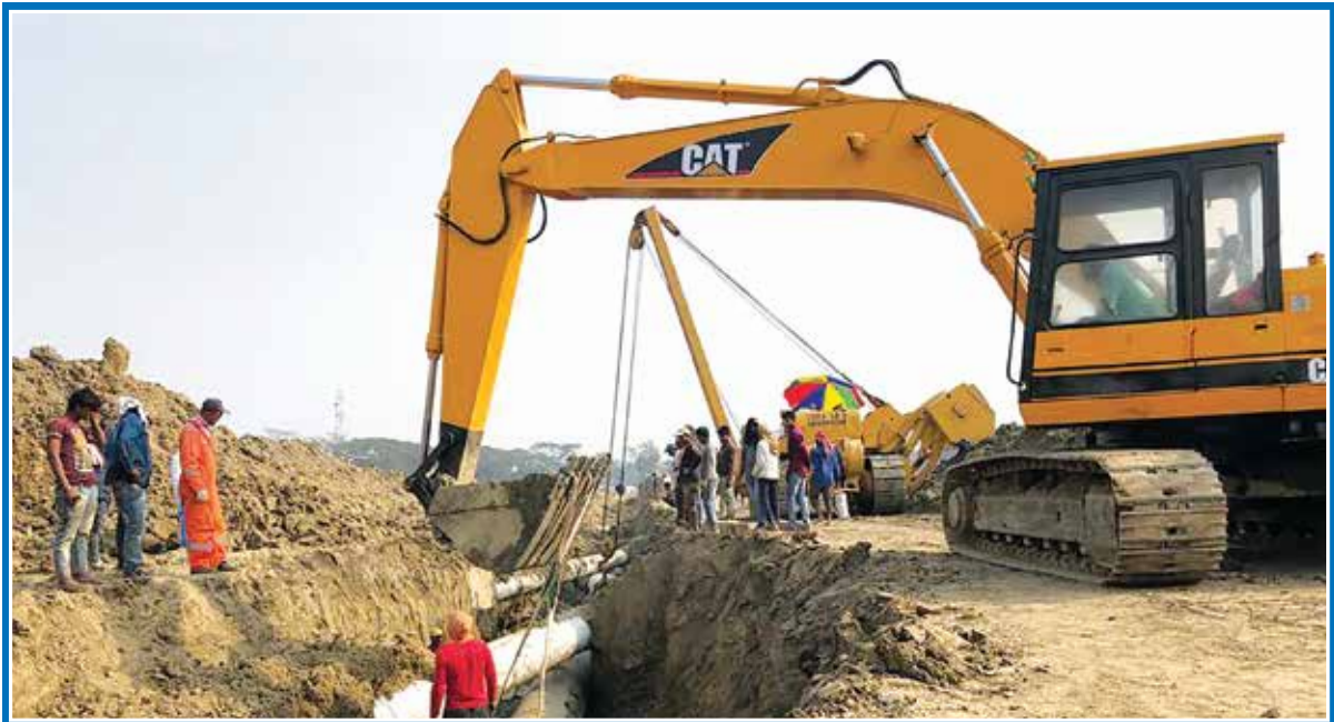
৩৬" ব্যাসের পাইপলাইন স্থাপনকালে বিদ্যমান ২৪" ব্যাসের সঞ্চালন পাইপলাইন অতিক্রমণ
